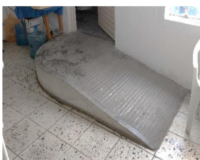
Rampa en entrada a sanitario – U.B.R.
