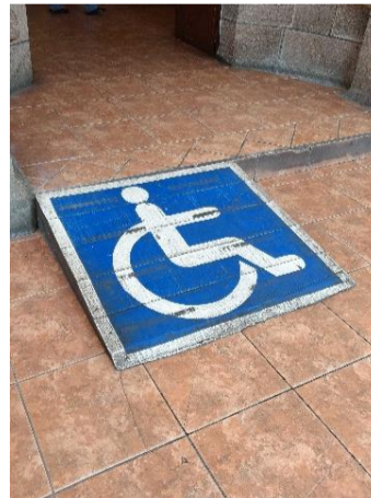
Rampa en entrada principal – Presidencia Municipal
