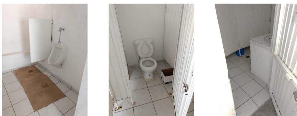
Sanitarios – SIAPA Tepic
