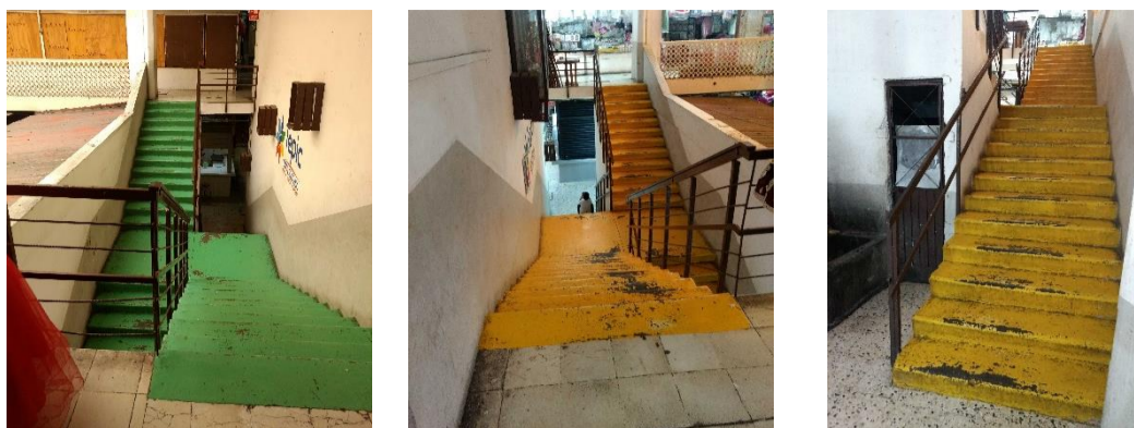
Escaleras – Mercado Municipal
