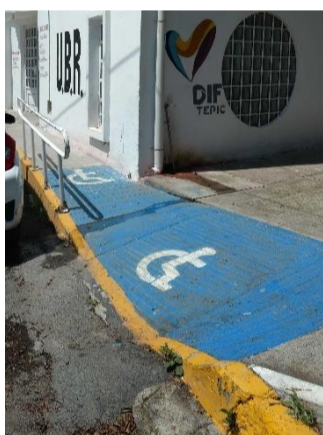
Rampa en banqueta – Centro Integral de Atención a Personas con Discapacidad
