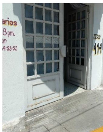
Rampa en entrada – Unidad Básica de Rehabilitación
