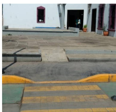
Rampas en ruta de acceso – Casa de la Cultura
