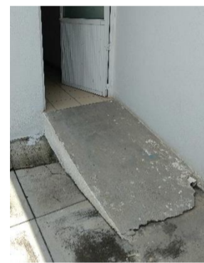
Rampa en puerta de oficina – D.I.F. Municipal
