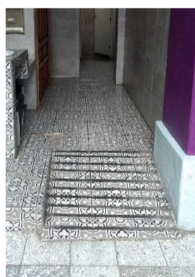
Rampa en pasillo de acceso a sanitario – Presidencia Municipal
