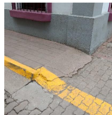
Rampa en banqueta – Presidencia Municipal
