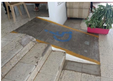
Rampa en pasillo – D.I.F. Municipal
