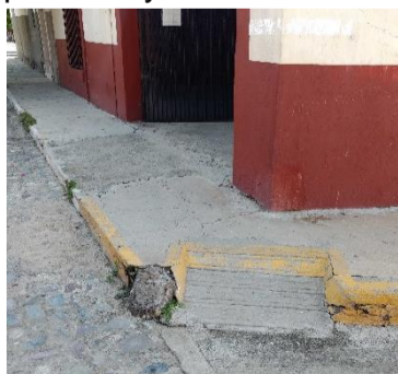
Rampa en cruce peatonal – Casa de la Cultura
