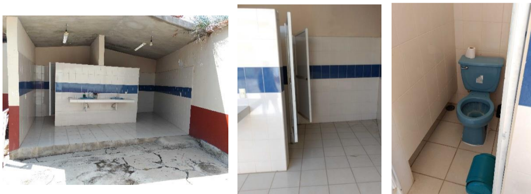
Sanitario – Casa de la Cultura
