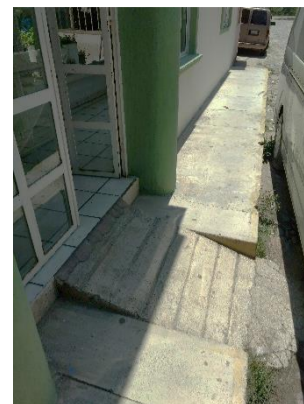
Rampa en acceso lateral – D.I.F. Municipal (U.B.R.)
