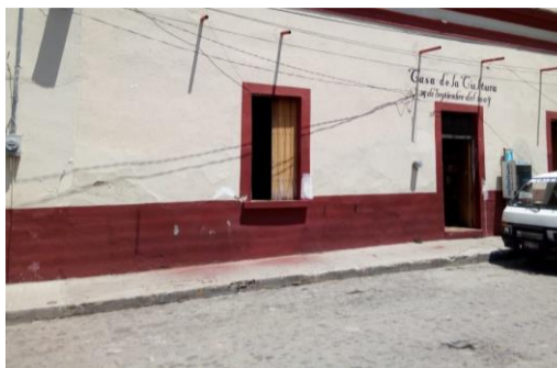
Ruta de acceso - Biblioteca Pública
