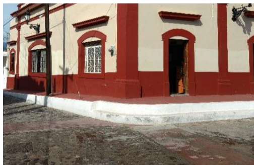
Banqueta en esquina de calle – Presidencia Municipal
