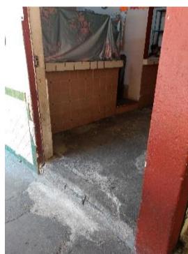
Puerta exterior – Mercado Municipal
