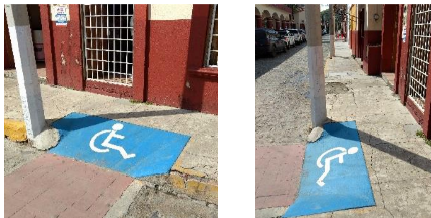
Rampa en banqueta – Ruta de acceso a Presidencia Municipal
