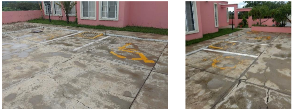
Estacionamiento reservado - Unidad Básica de Rehabilitación
