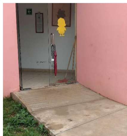
Rampa en acceso principal – U.B.R.
