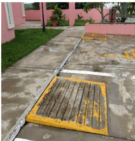
Rampa en estacionamiento – U.B.R.
