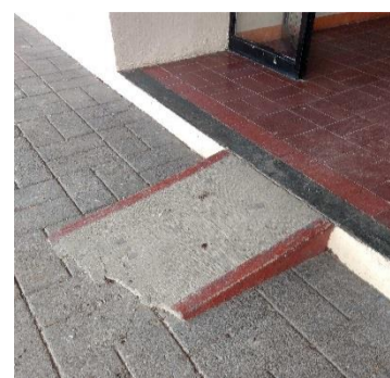
Rampa en acceso – Presidencia Municipal
