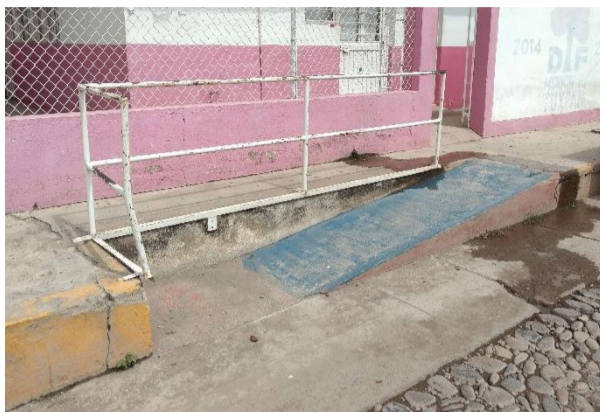
Rampa en banqueta – D.I.F. Municipal
