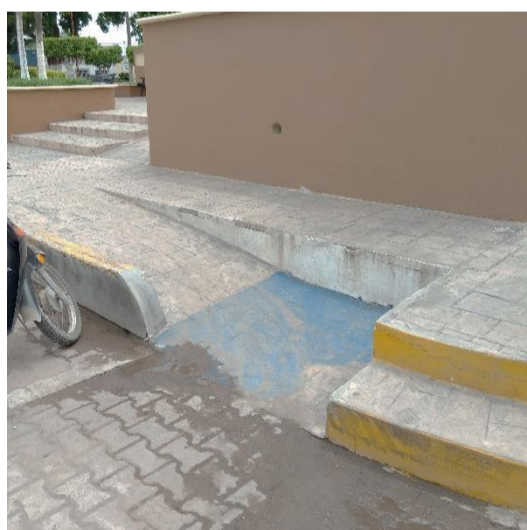
Rampa en banqueta – Plaza Principal
