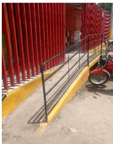
Rampa doble – Mercado Municipal (calle Morelos)
