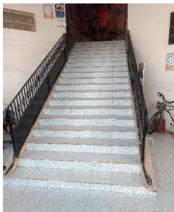
Escalera (primer tramo) – Presidencia Municipal
