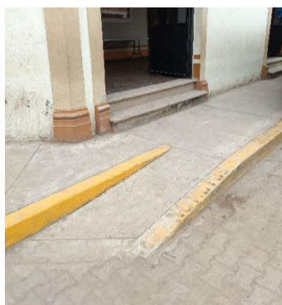
Rampa en banqueta - Auditorio Municipal
