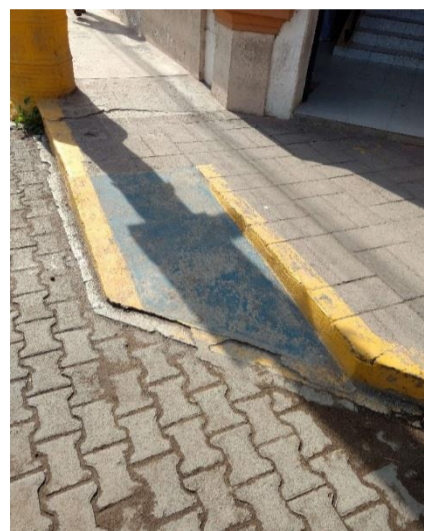
Rampa en banqueta – Presidencia Municipal
