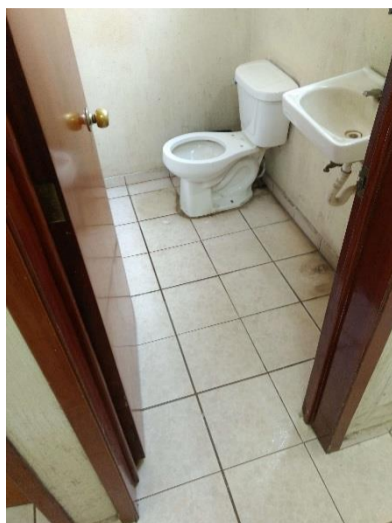
Sanitario – Edificio Administrativo
