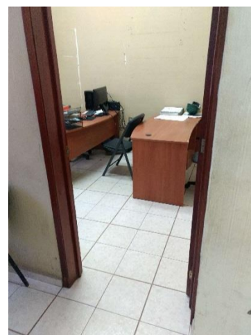
Puerta Interior – Edificio Administrativo
