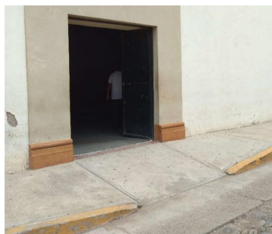
Rampa en acceso lateral – Auditorio Municipal
