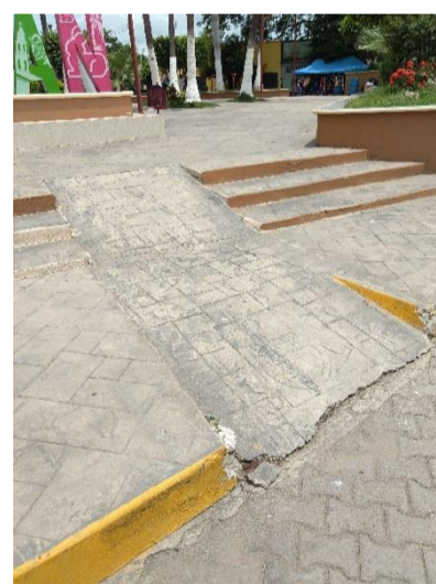
Rampa en banqueta – Plaza Principal
