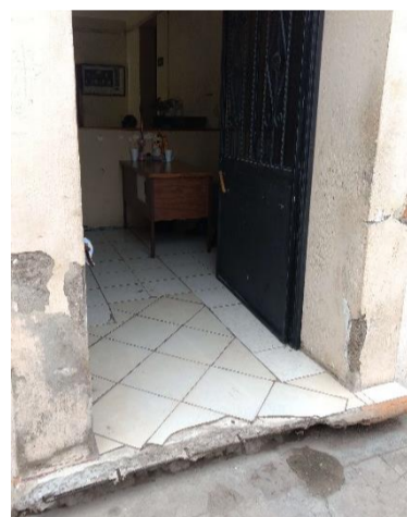
Puerta Principal – Edificio Administrativo
