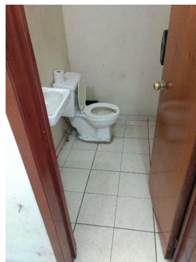
Sanitario – Edificio Administrativo
