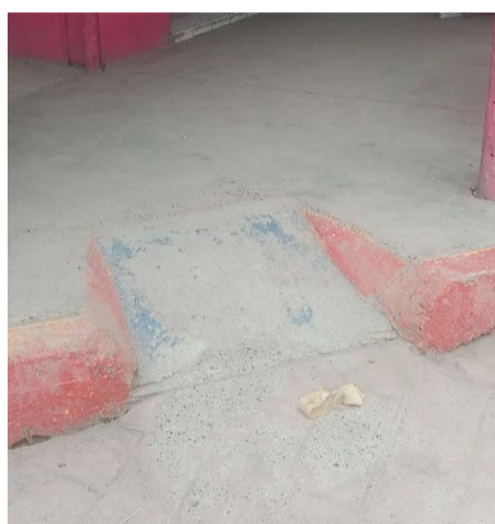
Rampa en banqueta – Mercado Municipal (Esquina Independencia y Victoria)
