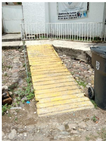
Rampa en banqueta – D.I.F. Municipal
