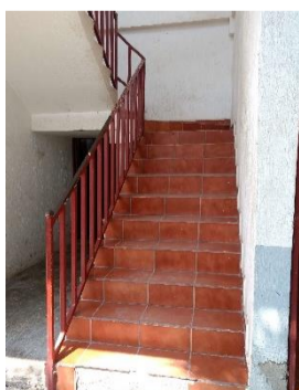
Escalera - Edificio Administrativo
