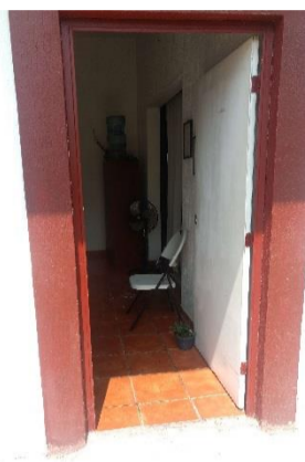
Puerta Interior - Edificio Administrativo (UBR)
