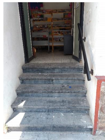
Puerta Exterior – Biblioteca Pública
