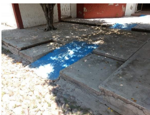
Ruta de acceso en D.I.F. Municipal
