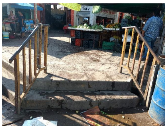
Escalera - Mercado Municipal
