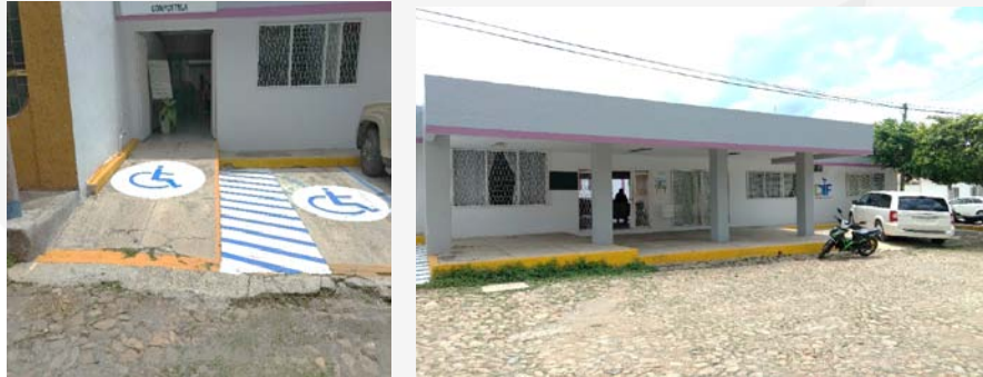
Rampa en acceso/Ruta de acceso - DIF Municipal
