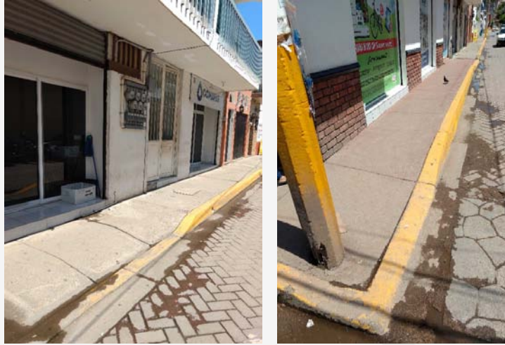
Rampa en banqueta/cruce peatonal - OOMAPAS
