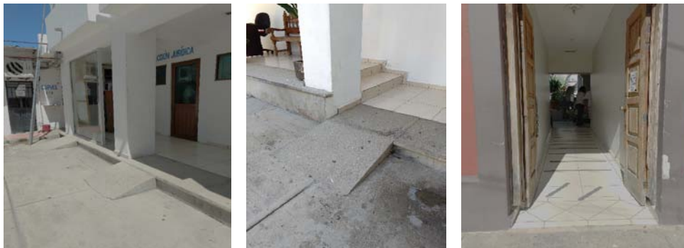
Rampas y pasillo - Presidencia municipal
