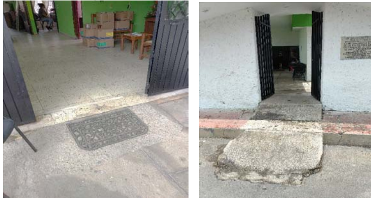
Rampas en guarnición y en puerta exterior – D.I.F. Municipal
