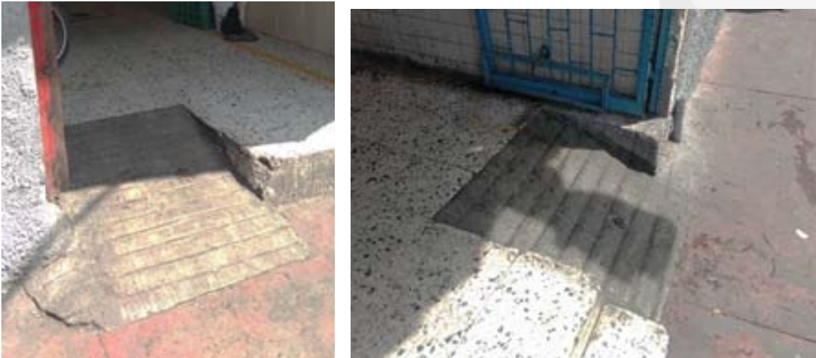
Rampas en entradas de calle Puebla – Mercado Municipal
