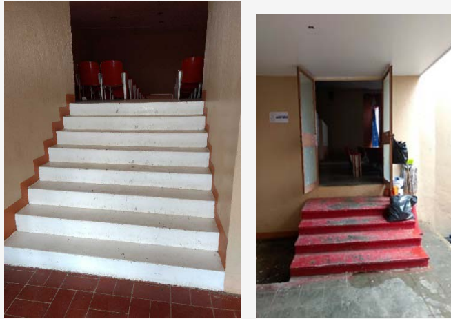
Escaleras – Accesos al Auditorio de la Presidencia Municipal
