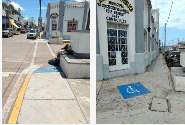
Rampa en banqueta – Presidencia Municipal, Biblioteca Pública
