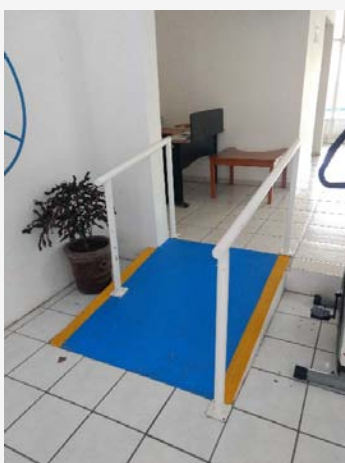
Rampa en espacio de servicio al público – Unidad Básica de Rehabilitación del D.I.F.
