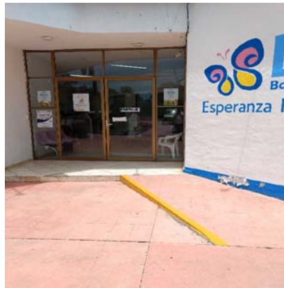
Rampa en entrada principal – D.I.F. Municipal
