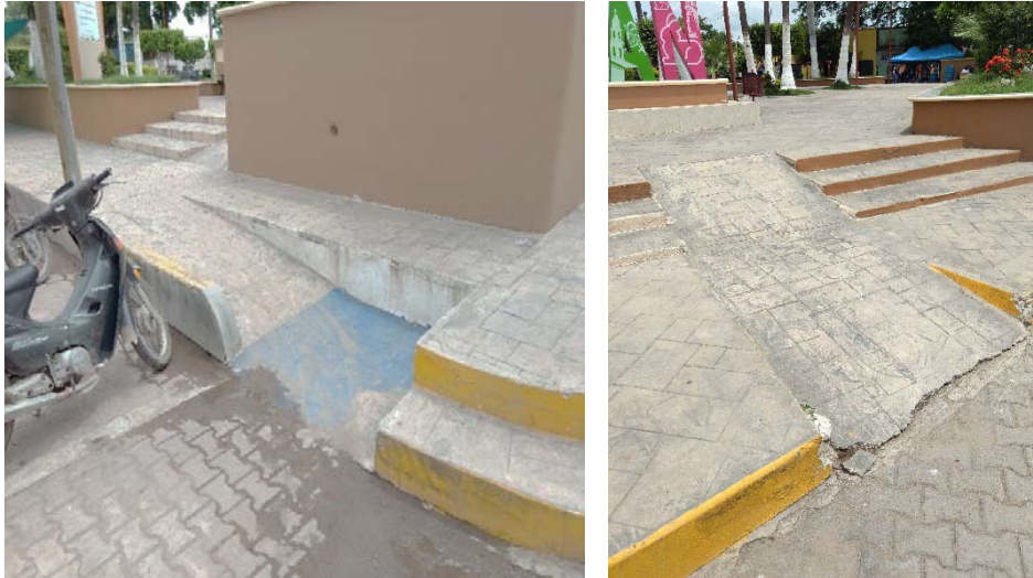
Rampa en banqueta - Plaza principal
