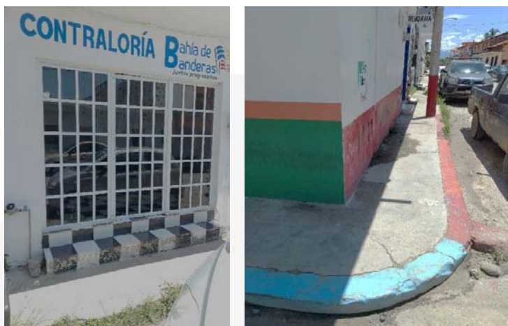
Escalones y puerta - Contraloría municipal
