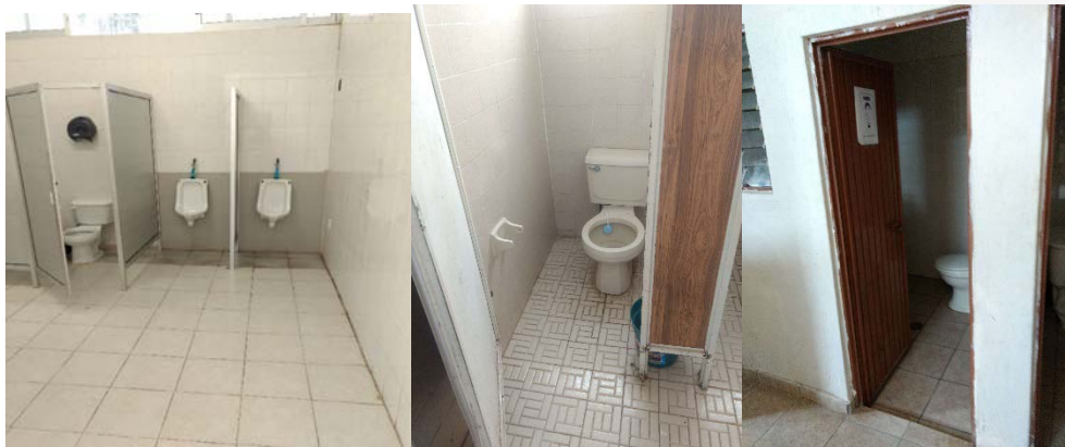
Sanitario - Presidencia municipal/DIF Municipal/Biblioteca Pública
