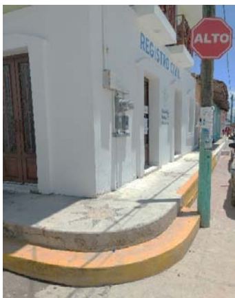
Banqueta en esquina – Dirección del Registro Civil
