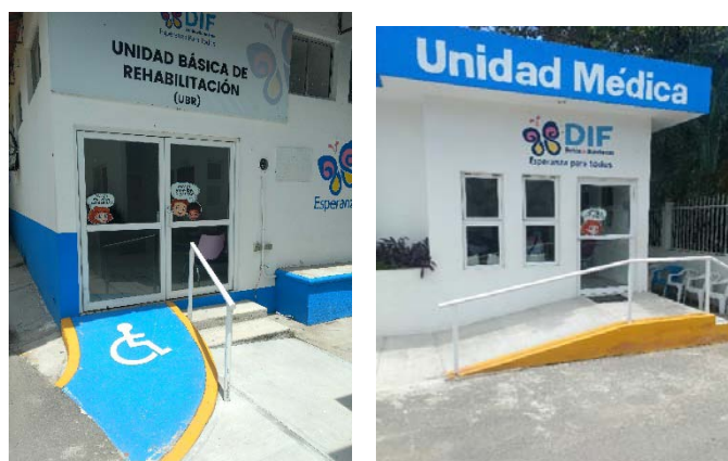
Rampa en acceso – Unidad Básica de Rehabilitación del D.I.F. Municipal
