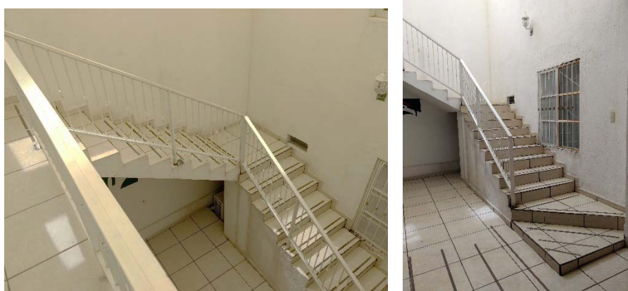
Escalera (acceso lateral) – Presidencia Municipal
