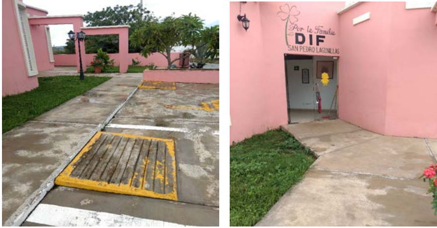
Rampa en estacionamiento/acces principal - UBR
