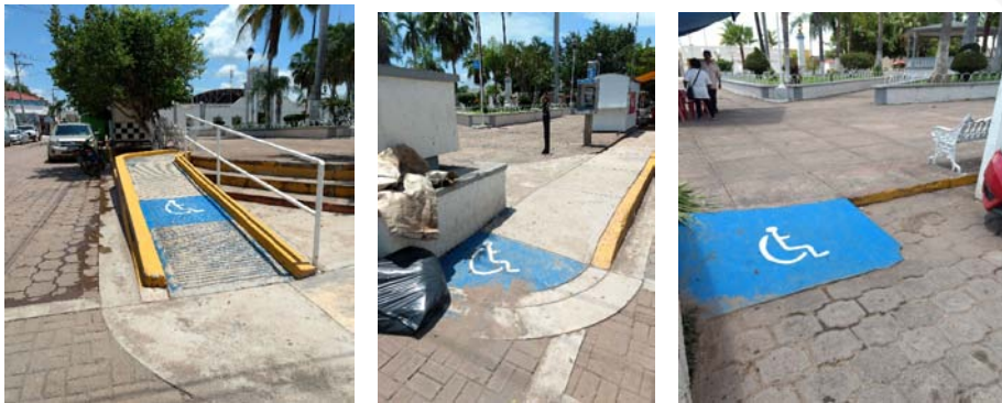
Rampa larga/Rampas en guarnición y banqueta – Plaza Principal
