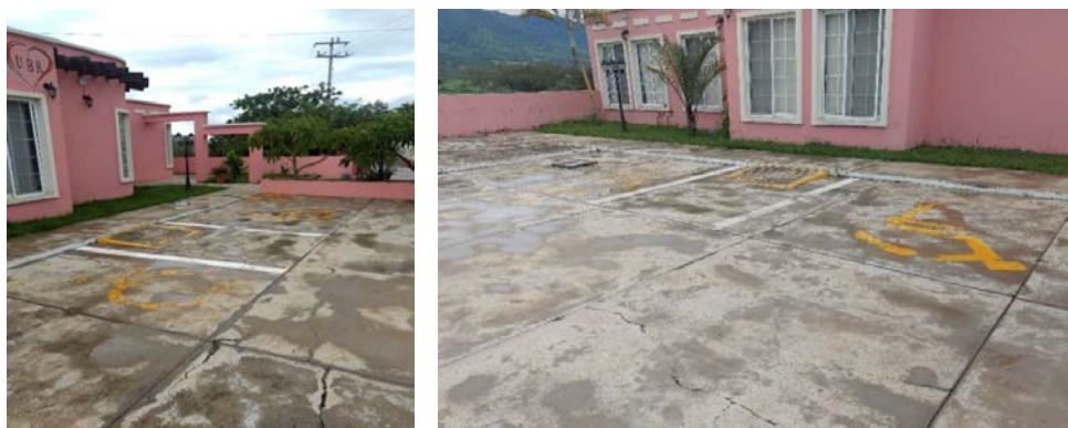
Estacionamiento reservado - Unidad Básica de Rehabilitación
