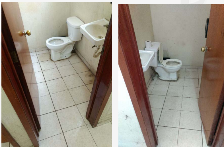
Sanitario - Edificio administrativo
