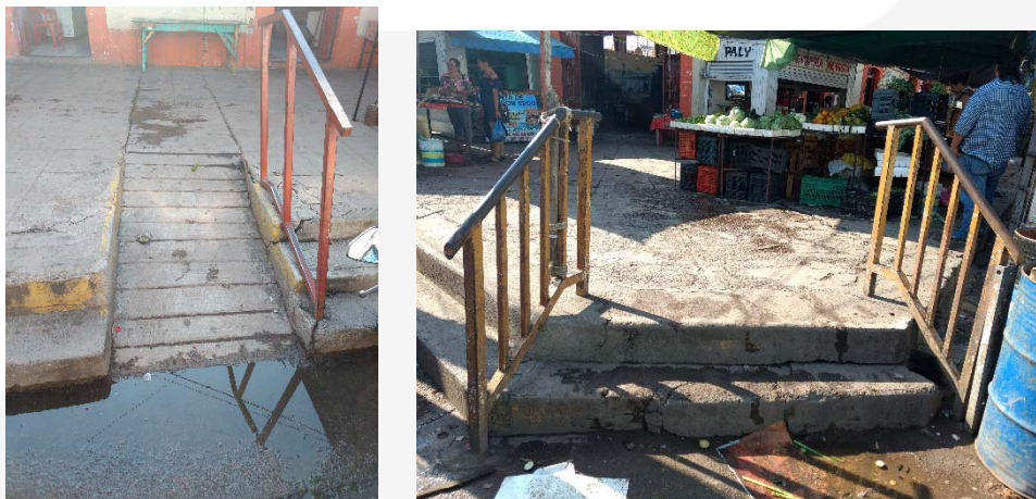
Rampa/Escalera - Mercado municipal
