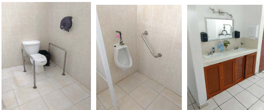
Sanitario – Unidad Básica de Rehabilitación del D.I.F. Municipal
