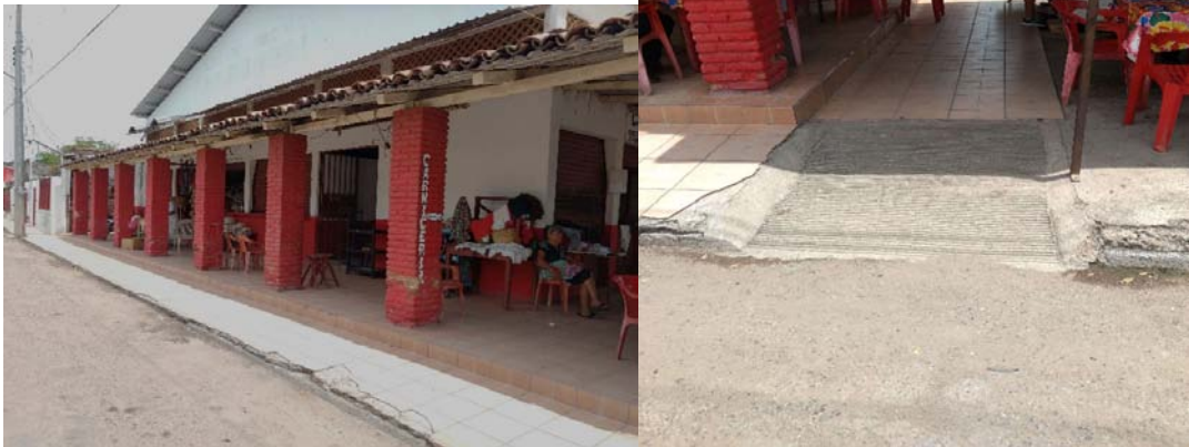
Ruta de acceso/rampa en banqueta - Mercado Municipal
