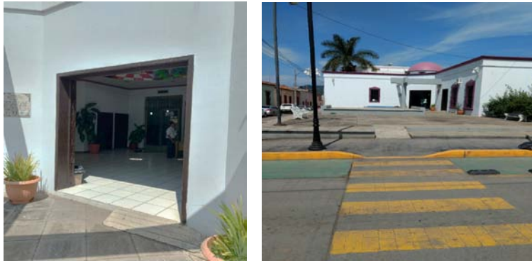
Rampa en acceso principal – Casa de la Cultura
