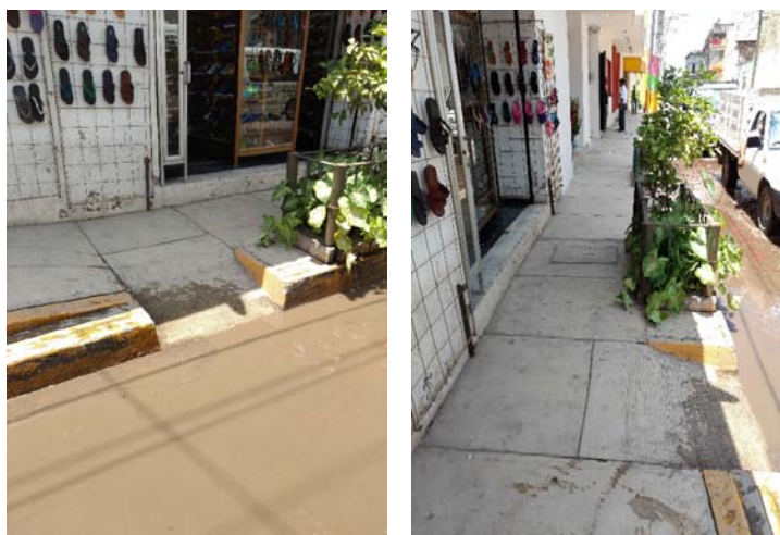
Rampa en banqueta - Teatro Ixcuintla
