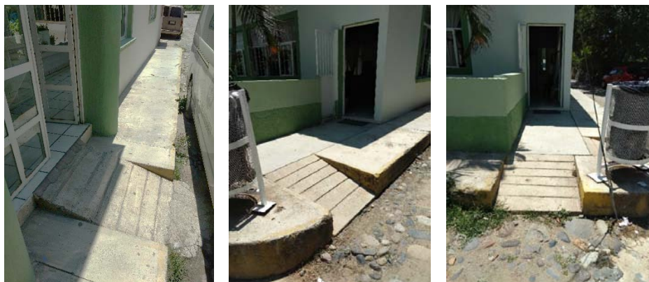
Rampas en cruce peatonal – D.I.F. Municipal
