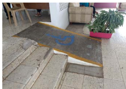
Rampa en pasillo – D.I.F. Municipal
