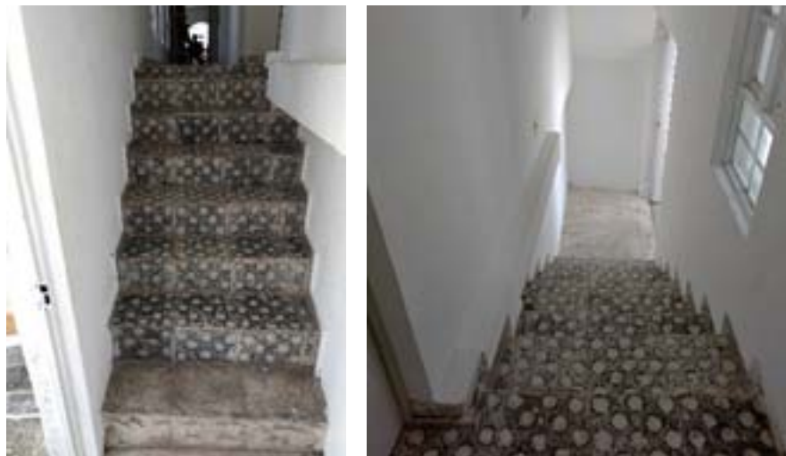
Escalera – Biblioteca Pública Municipal “Sofía Curiel Santiago”
