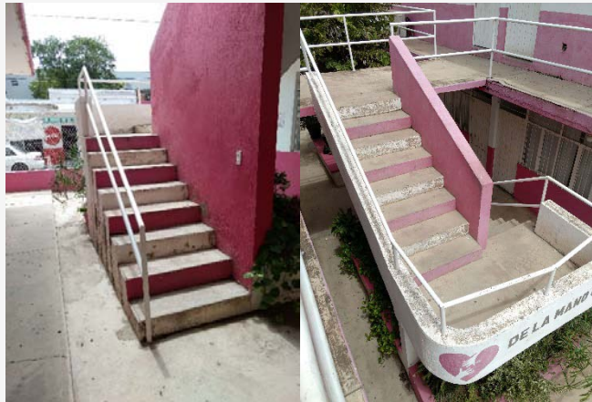
Escalera - DIF Municipal
