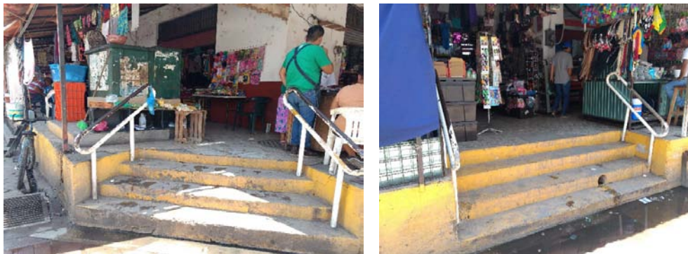
Escaleras - Mercado municipal
