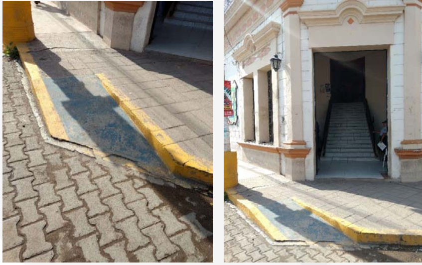
Rampa en banqueta/Rua de acceso - Presidencia Municipal
