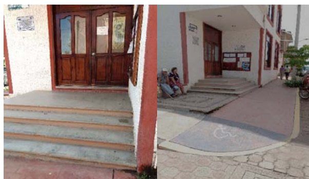
Escalera de acceso/Rampa en banquetta - Edificio administrativo
