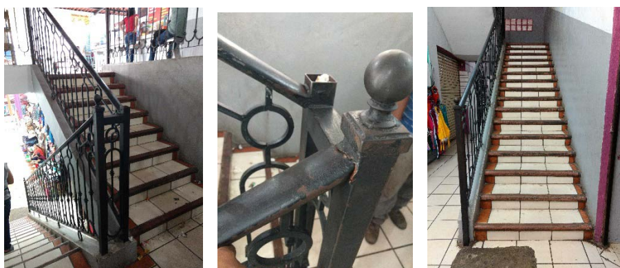
Escalera/Pasamanos - Mercado municipal
