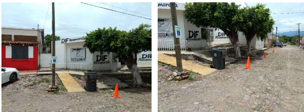
Espacio de estacionamiento reservado sobre la vía pública – DIF Municipal
