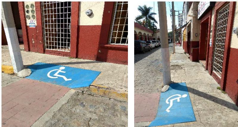
Rampa en banqueta – Ruta de acceso a Presidencia Municipal
