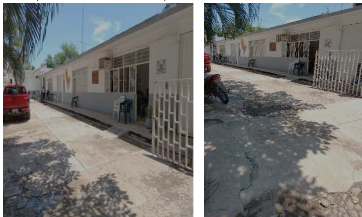
Rampa y entrada vehicular - DIF Municipal
