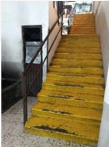
Escaleras – Mercado Municipal
