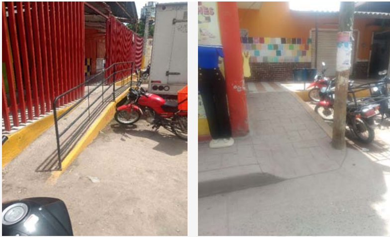
Rampa doble/rampa en banqueta - Mercado municipal
